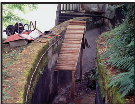
Goizuetako Rezolako zentralaren gainaldeko ubidean, animaliak irteteko jarritako sistema. Hondora lotutako euskarrien bidez, egurrez egindako malda bat da.
