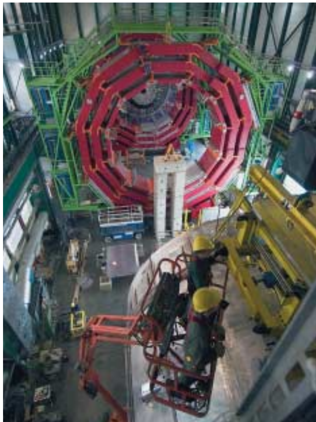
CMS detekttagailua instalatzeko lanak. Detekttagailu honetan saiatuko dira nagusiki Higgs bosoa detektatzen.
