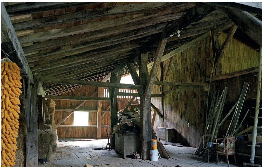
Zela baserriaren ganbara (Ezkio). Susperregik zehaztu ahal izan du baserri hau egiteko zuhaitzak 1453an bota zirela. ARG.: Ibon Telleria.
