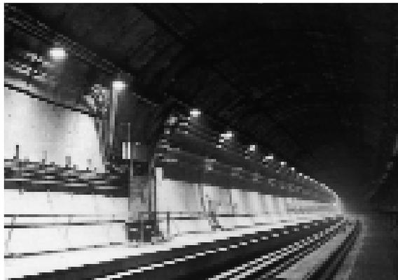
Galeria honetan 2,5 m-ko altueran 9 metroko lanpara bat ipini da. Lanpara-kopuru horri tren-tunelekin lotzeko pasiloetan dauden lanparak gehituz, guztira 6.700 lanpara ateratzen dira.
