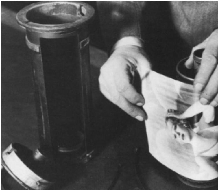
1930.eko hamarkadan dokumentuak danbor batean eusten ziren igortzeko. Faxerako behar zen tresneriak leku handia behar zuen eta telefono-linea bereziak bakarrik erabil zitezkeen.
