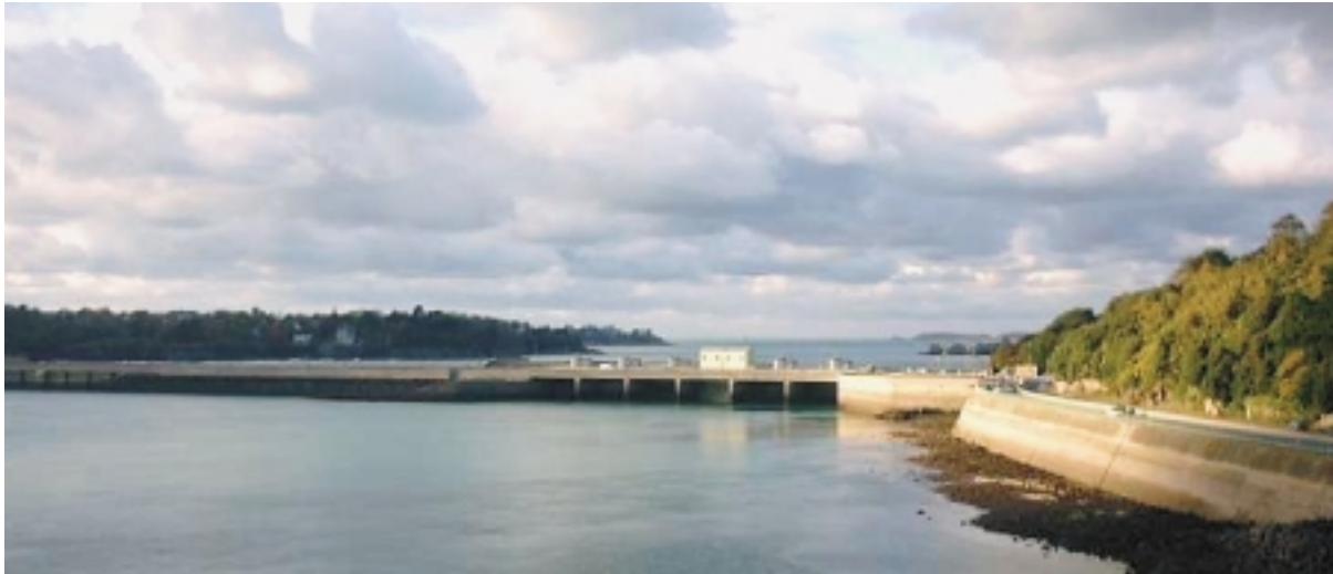
La Rance-ko estuarioko presa. Gainetik errepidea pasatzen da, eta azpialdean energia ekoizteko turbinak kokatzen dira. 1967az gero ari da lanean, eta urteko 600 milioi kWh sortzen ditu.
