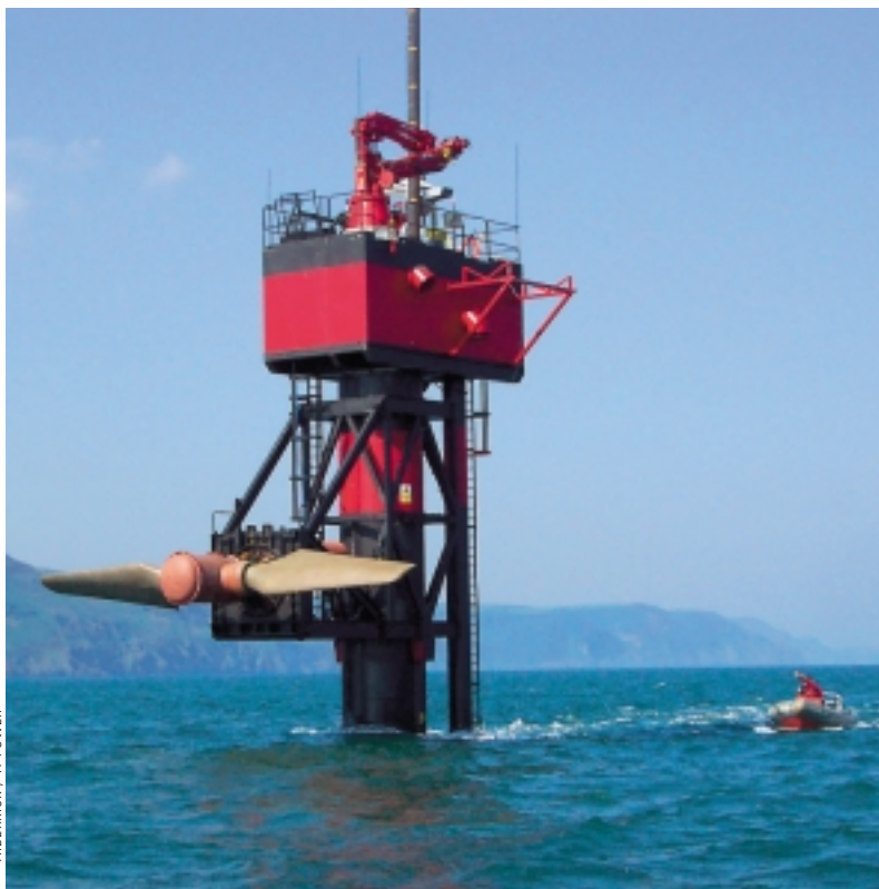
IT Power enpresaren instalazio pilotua, Bristolgo kanalean. 300 kW ekoizteko gai da. Helizea ardatzetik irrinstatzen da, ur azpian egoki den sakoneran jartzeko.
