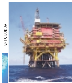
Sakonera txikiko tokietan plataforma hankadunak instalatzen dira, eta hanka horiek oso egitura konplexuak izaten dituzte.
