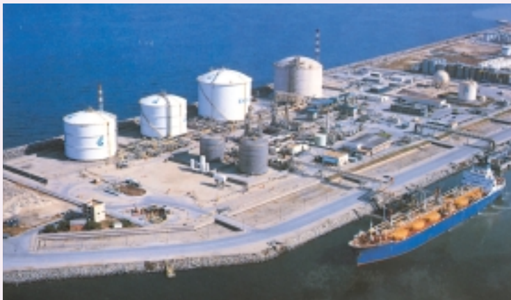
Gas natural likidotua birgasifikatzeko instalazioa.
