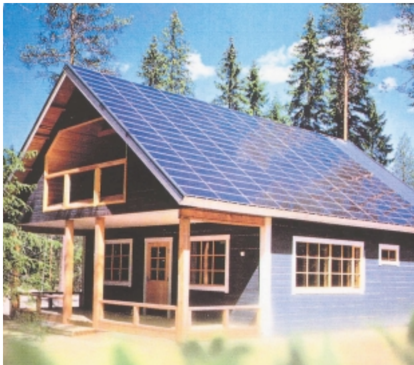
Eraikinean integratutako instalazio fotovoltaikoa.
