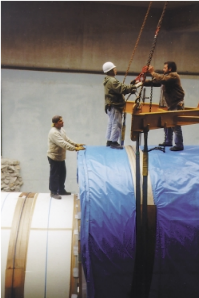
Metakrilatozko tunelak jartzea zehaztasuneko lana izan zen.
