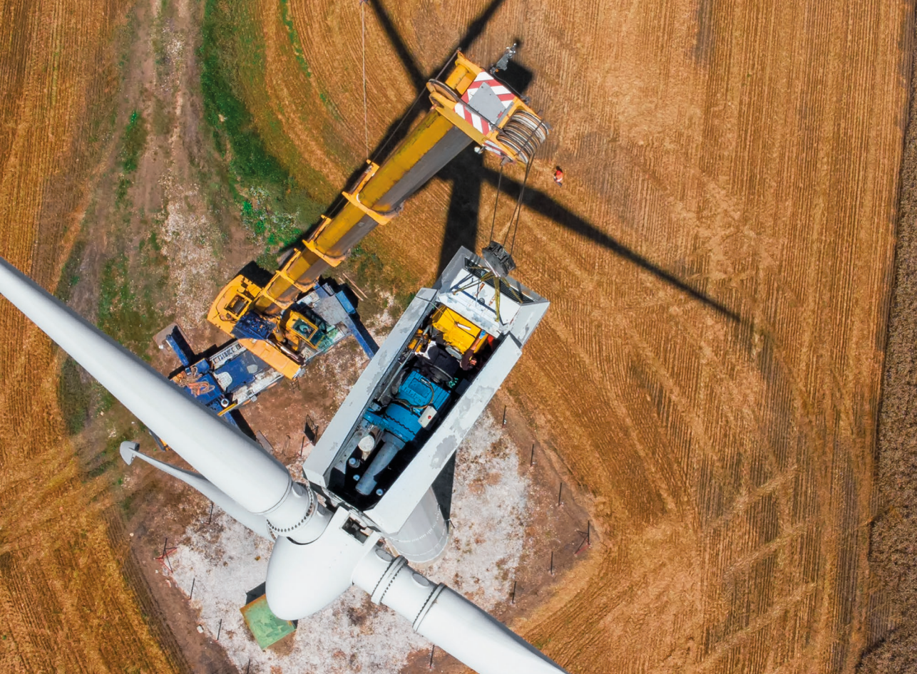
1 MW-eko aerosorgailu batek (gehienak hortik gorakoak dira), 3.000 kg kobre, 780 kg manganeso, 400 kg nikel eta 14 kg lur arraro (neodimioa, praseodimioa...) ditu. ARG.: mstoyanov/Shutterstock.com.
