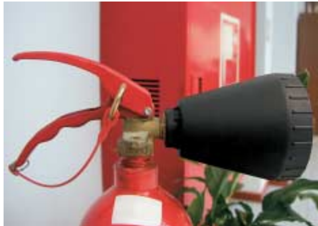
Karbono dioxidodun su-itzailgailuek tronpeta-itxurako iragazki bat dute. Hauts kimikoak dituzten su-itzailgailuek, berriz, ez.
