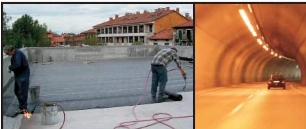
Xafla iragazgaitzak asko erabiltzen dira azpiegiturak eraikitzean, esaterako, etxeetan edo tuneletan.
