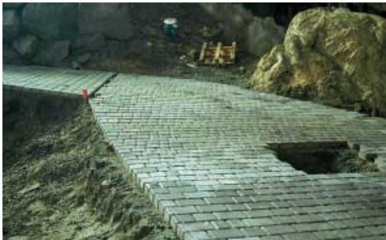
Zorua buztintua den lekuetan galtzada-harria jarri dute, harri-txintxar eta hareazko geruza baten gainean. Horri esker, ez da aldatzen urak berez egiten duen bidea.
