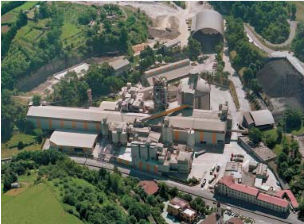
Garai batean, grisak izaten ziren zementu-fabriken inguruak. Gaur egun arazo hori gainditu dute.
