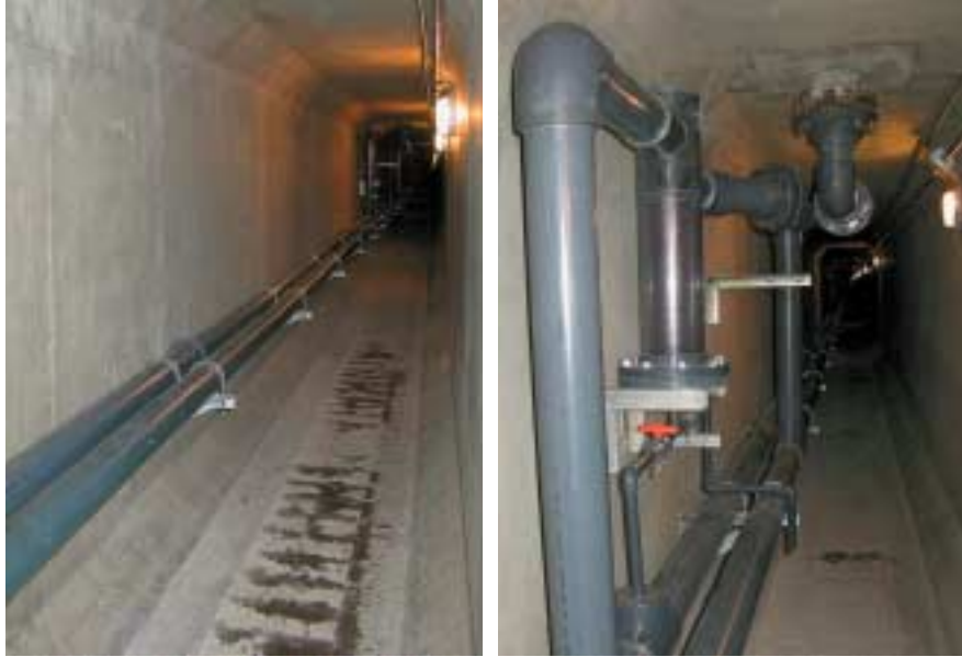
Plataformen azpian, infiltrazioak kontrolatzeko sarea eraiki dute. 300 urtez, ura ez dela iragazten eta ez dela hondakinekin kontaktuan jartzen kontrolatzeko dago prestatuta.
