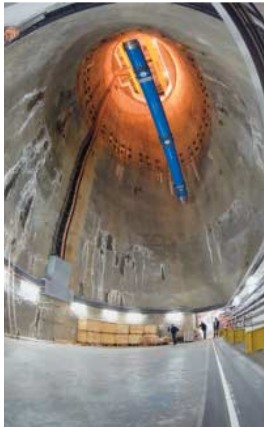
Azeleragailuaren hodia zatika jaitsi zuten lurrazaletik instalatu ahal izateko.
